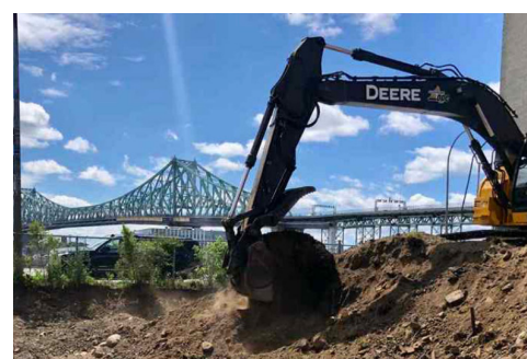
Remuement du sol/ Excavations
